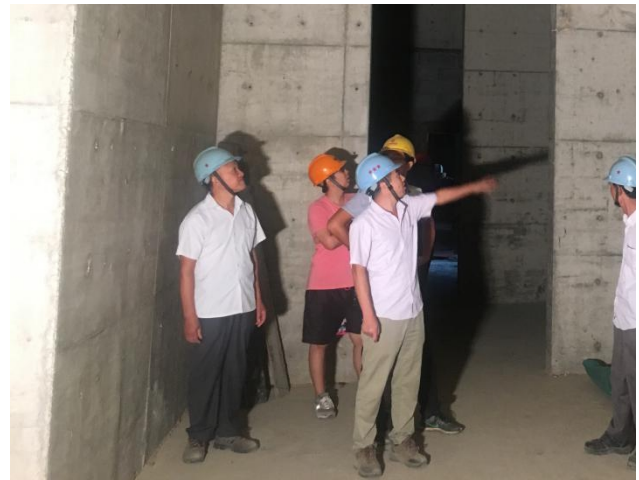
图1 建筑工程监理验收
