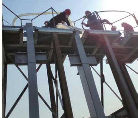
图 4 采用钢管柱工厂预制灌浆
