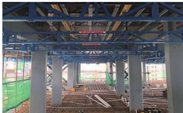
图 1 倒挂式支撑系统
