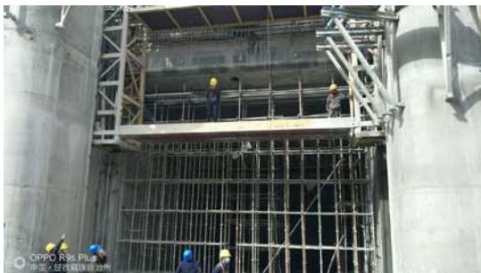
图 1 闸门门槽混凝土与埋件一次成型的施工
