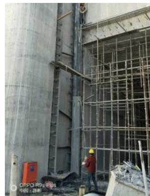
图4 台车提升现场施工图
