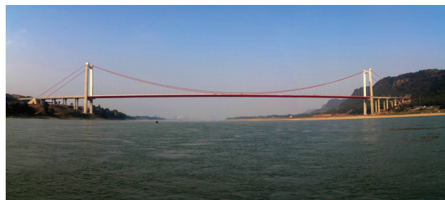
图19 南溪长江大桥实景图
