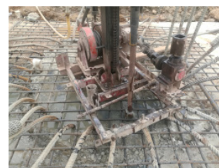
图2 钻芯机通过声测管疏通到桩底
