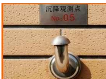
图2-2 建筑物竖向位移监测点实物图
