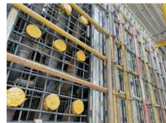
图11 S弯管模板加固
