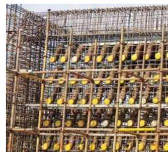
图12 S弯管墙体安装
