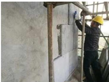
图2 节能墙体施工图
