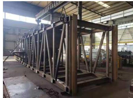
图1 特制吊架实拍
