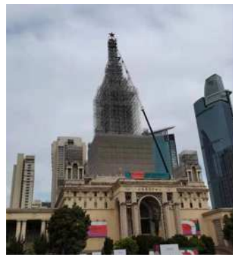
图3 脚手架搭设实景图
