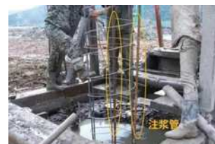
图3 钢筋笼定位
