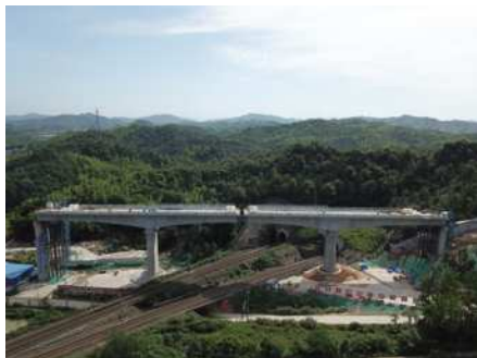
图1 转体梁现场施工图
