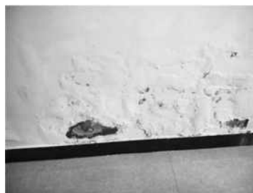
图1 墙体剥落图
