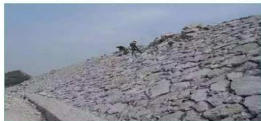
图5 路基边坡码砌施工图片
