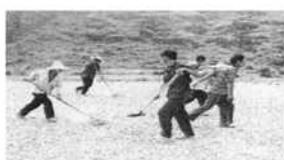
图2 人工整平路基表面
