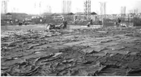
图1 大体积混凝土养护作业图
