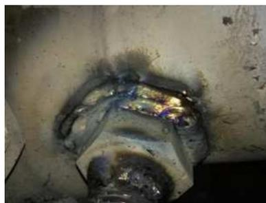
图3 补焊后的焊道
