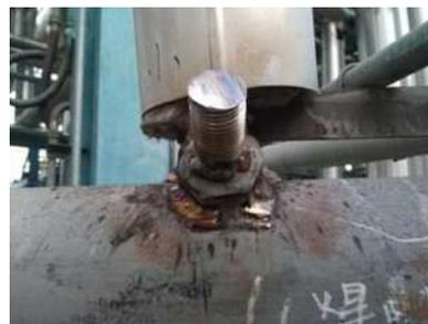
图4 补焊后的焊道
