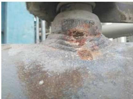
图2 管线与热电偶连接焊道裂纹
