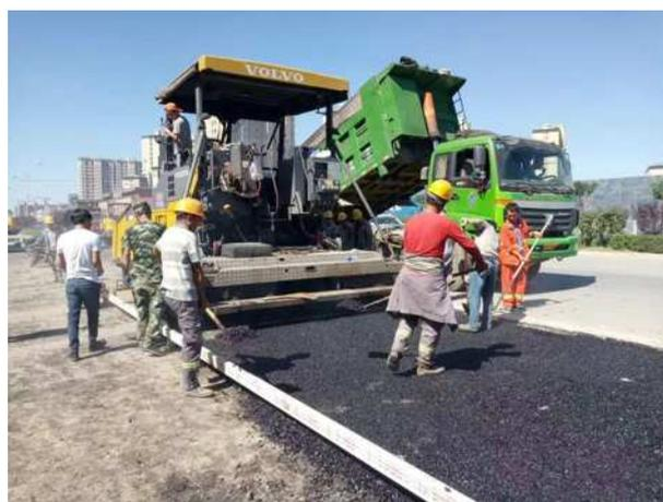
在对市政道路的路面进行铺摊之前,相关施工人员应对可能影响施工质量的各种因素进行全面分析、综合考虑,充分利用有利于道路施工的因素,对施工不利因素采取相应措施,避免对市政道路的质量产生影响。在有利的季节进行道路路面的铺摊施工,充分利用其有利因素,进而保证道路路面的施工质量。在道路路面进行铺摊施工前,相关施工人员应该严格控制其施工相关的参数,例如,在道路路面的铺摊施工前,应对水准点的定位工作进行严格把控,同时,施工人员可以依据搅拌机的产量、铺设尺寸等参数来对设备的铺摊速度进行合理控制,进而确保道路路面的铺摊质量。相关施工人员在利用机械设备对道路路面进行铺摊时,应保证道路铺摊均匀程度,禁止随意改变铺摊速度,同时,在十字路口等道路特殊位置进行铺摊施工时,施工人员应对其及时进行修正处理,其余道路的施工路段不允许施工人员进行随意修
