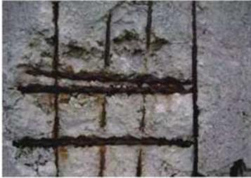
图4 钢筋被腐蚀图
