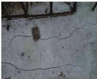
图5 收缩裂缝
