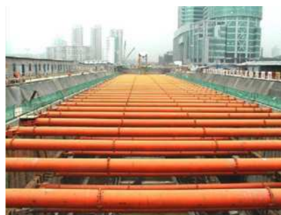
图1 明挖基坑钢支撑体系
