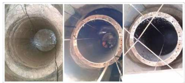
图 6 墩柱成孔、清理桩头、柱模校正照片
