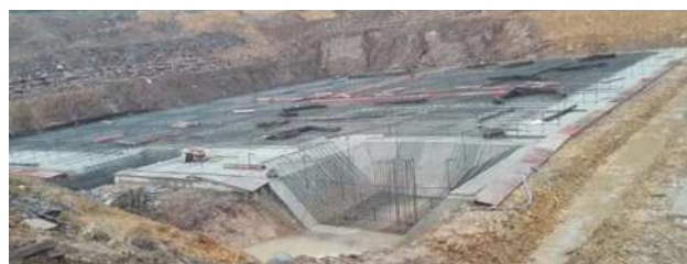
图1 某水利水电工程施工现场图
