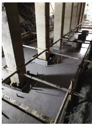
承台混凝土浇筑
