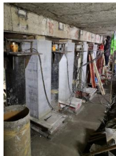
临时支撑及新做立柱
