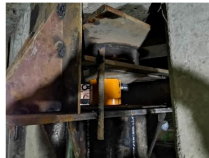
临时支撑顶部千斤顶
