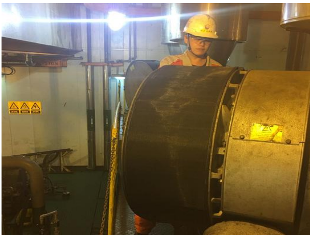
图 19 现场安装外置滤网
