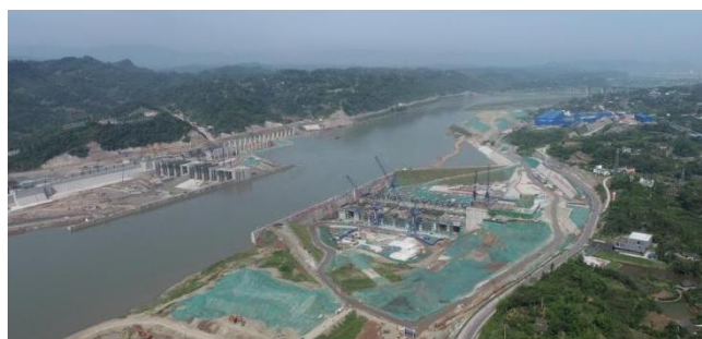
图1 岷江龙溪口航电枢纽工程(左岸发电厂房、右岸通航船闸)
