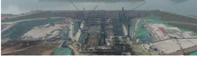
图2 岷江龙溪口航电枢纽工程（厂房全年围堰）
