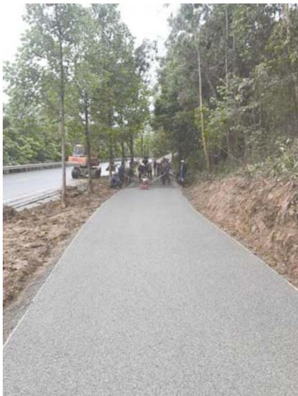
面层施工必须计算松铺高度,合理控制高度能够使压实后与周边的铺装材料(或模板)高度一致,符合道路面层的设计高程,松铺摊平后采用低频液压工作碾进行滚平碾压,以保证路面混凝土的密实性,从而保证混凝土的强度。滚平碾压后及时用混凝土磨光机械磨平,周边磨光机无法磨到的地方用人工抹平,要求表面平整,石子分布均匀,无缺失石子现象,禁止有积浆现象无液压。
