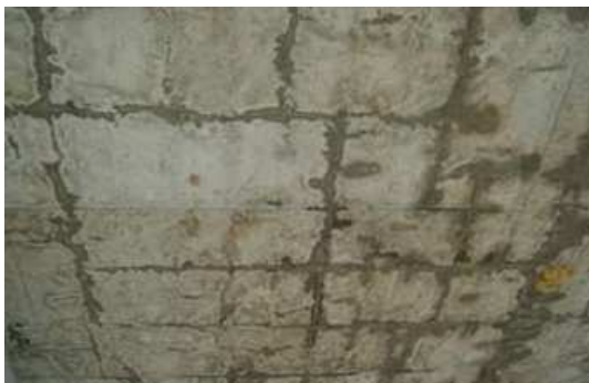
图1 温度裂缝
