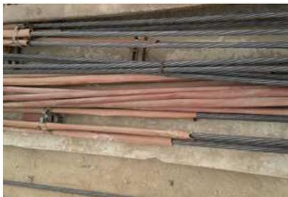
(5) 注浆管随锚体一起放入钻孔,注浆管距孔底5-10cm,锚体放入角度与钻孔角度一致。锚体放入孔中长度不小于锚索长度的95%。将锚索体推送至预定深度后检查排气管和注浆管是否畅通。
