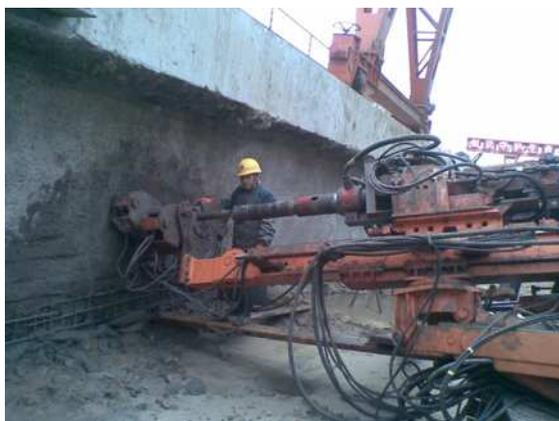
(1) 由于孔底标高在砂卵石地层中，锚索钻孔采用
