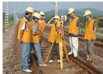
图1 铁路测量作业
