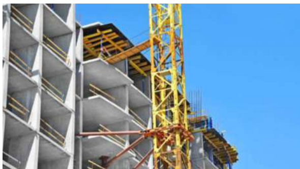
图2 高层建筑机电工程安装
