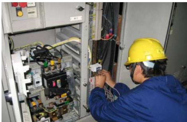
图1 建筑电气施工人员正在进行质量检修
