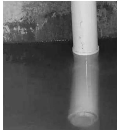
图4 闭水试验
