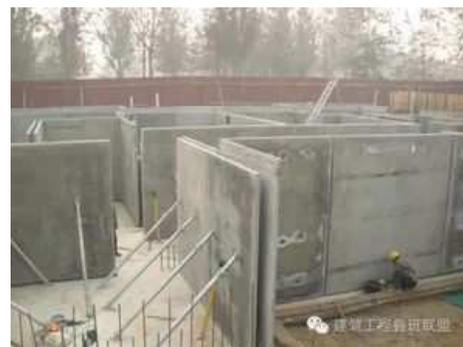
图2 装配式混凝土预制构件实景图展示
