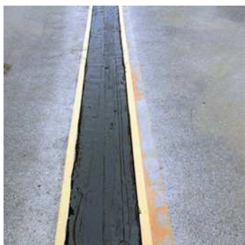
图1 无缝伸缩缝粘结料
