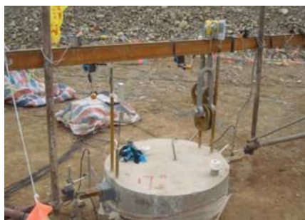
图3 精力压桩试验
