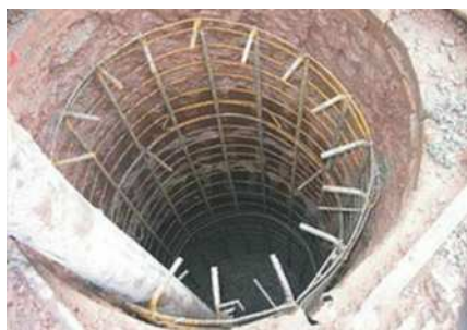
图2 混凝土灌注桩
