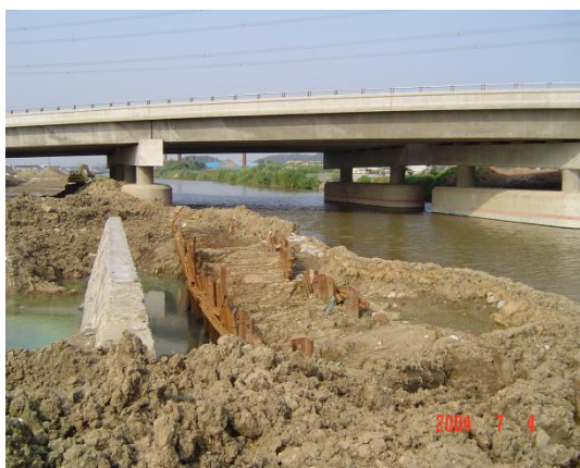
图4 土坝中打设双层钢板桩
