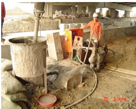
图7 压密注浆施工
