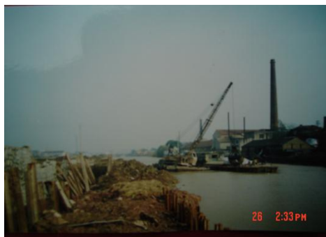
图 2 单排钢板桩围堰施工
