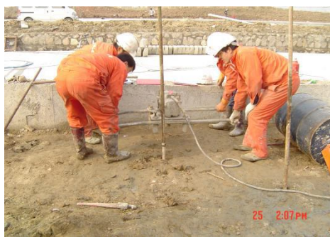
图8 压密注浆施工
