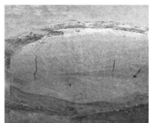
图2 磁粉检测表面裂纹
