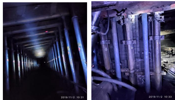
图3 前期补强支护及挡矸系统效果图
