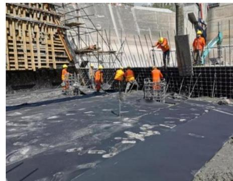
图8 连续坎“金”部分浇筑入仓图
