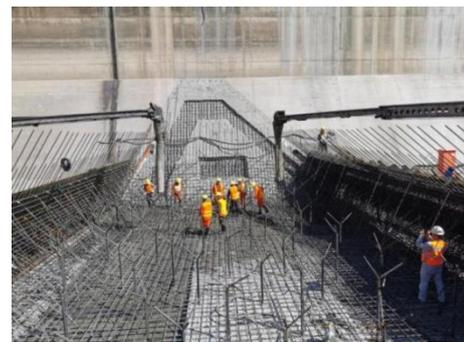
图7 连续坎“银”部分浇筑入仓图
