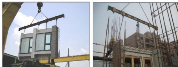
图 3-1-1 吊点可调式横梁吊装图
