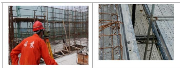
图 3-1-3 标高测量调节施工图
