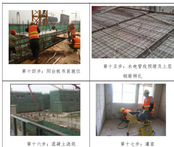
图 3-1-4 PC 构件施工图
