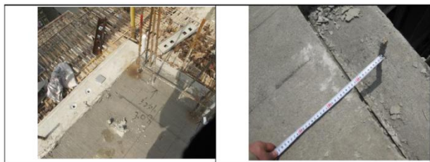
图 3-1-2 平面测量复核弹线施工图
