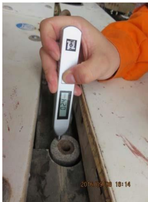
图4 现场前级泵振动值测试点
