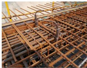
图2 梁侧封堵隔离
