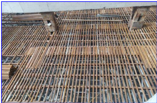
图 2-1：脚手架平台搭设
