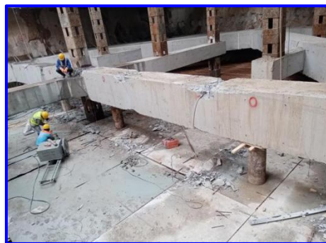
图 2-2：钢桶支顶切割
