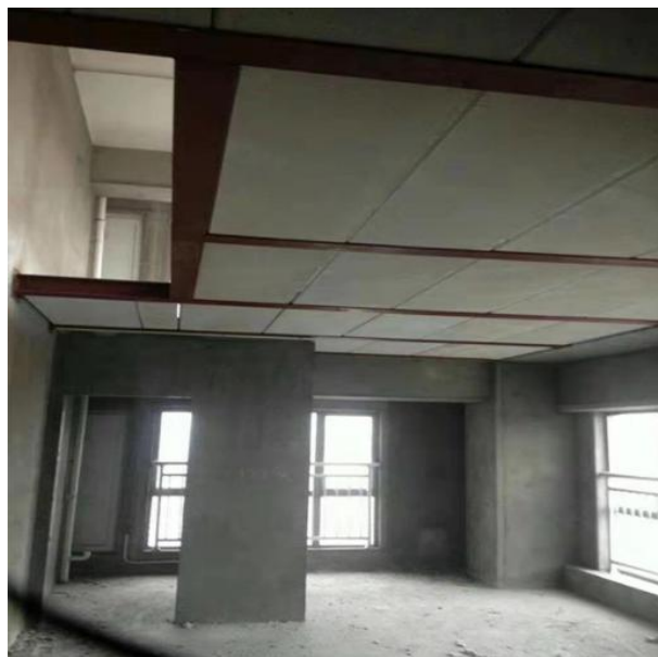
图1 装配式隔墙板在室内装饰中的应用
