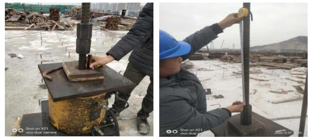
图8 精准控制吊杆下落
