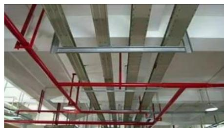
（5）插接式封闭母线段与段的连接口不应设置在穿越楼板或墙体处，垂直穿楼板处应设置与建（构）筑物固定的专用部件支座，其孔洞四周应设置高度为 50mm 及以上的防水台，并应采取防火封堵措施。如图所示：
