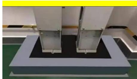
（6）插接式封闭母线段与段连接时，两相邻段母线及外壳宜对准，相序应正确，连接后不应使插接式封闭母线及外壳受额外应力；连接方法应符合产品技术文件要求；插接式封闭母线连接用部件的防护等级应与插接式封闭母线本体的防护等级一致。
