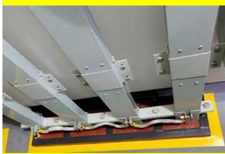
(9) 插接式封闭母线插接箱安装前，应打开插接式封闭母线插孔处的安全挡板，应先将箱内断路器推至 OFF 断开位置，将插接箱插脚按相序从插接式封闭母线插口处插入插接式封闭母线内，并保证插入到位。禁止带电插拔。插接箱安装后，应将其前后两处爪型卡板固定于插接式封闭母线两侧，并拧紧螺丝。内装大型断路器的插接箱，其垂直安装时，底部应加装承重托臂；水平安装时，应加装承重抱箍。
