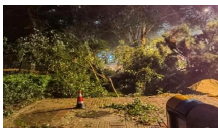
图 3 管线渗漏引发人行道地面塌陷
