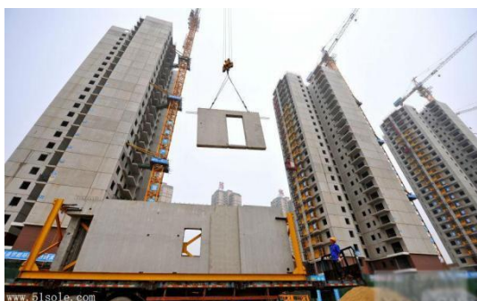
图3 构建吊装
