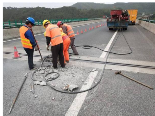
图2 开槽施工
