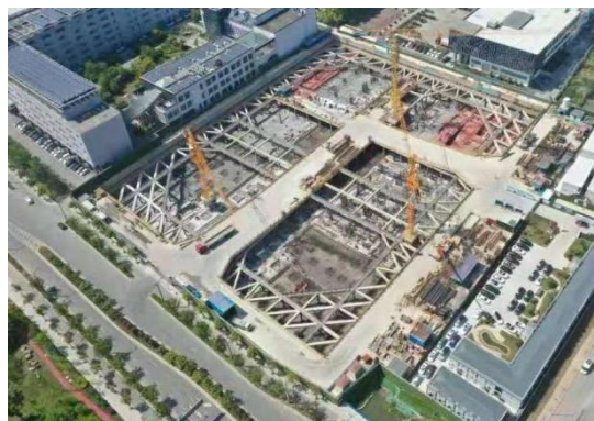
图 5 基坑开挖到底现状图
