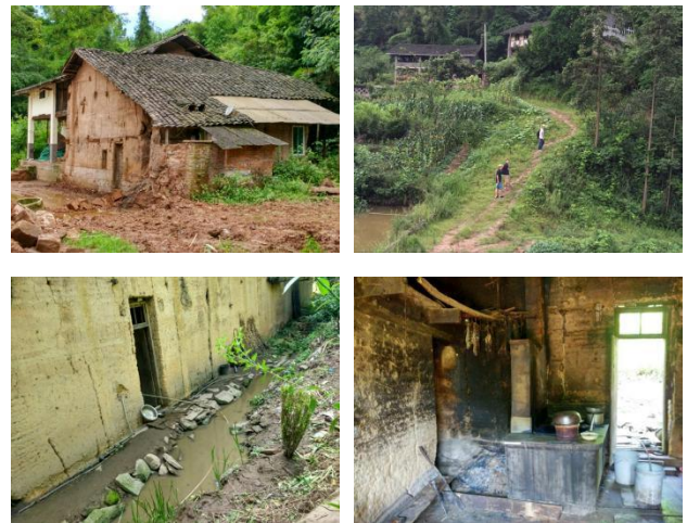
中江村部分居民房屋情况
