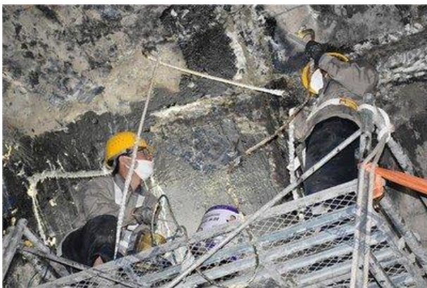
图1 隧道渗漏水病害治理
